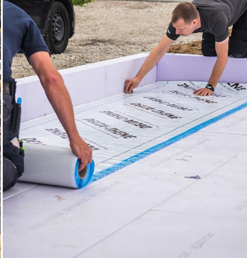
● Impermeabilità al gas radon su solette in contatto con il terreno – posa sotto la soletta in cemento su uno strato di ghiaia.
