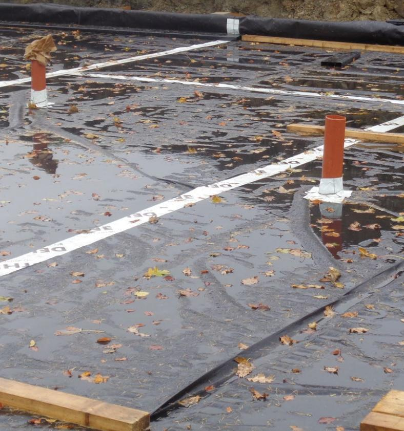
● Impermeabilità al gas radon sopra le solette in contatto con il terreno – posa sull'isolamento di un solaio di fondazione.
